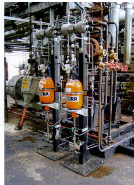
Pro Gleitringdichtung kommt jeweils ein Loopsystem zum Einsatz
